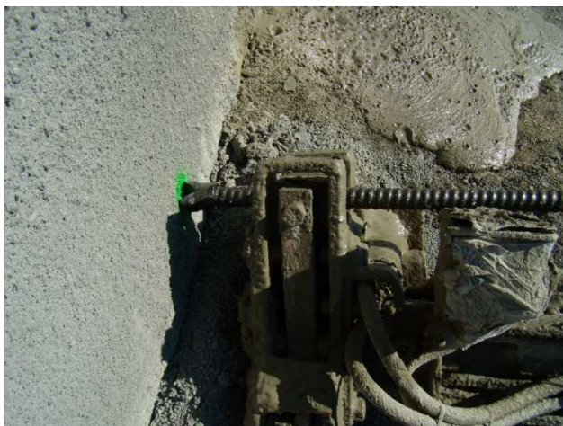
FOTO 3 - Inizio della perforazione
