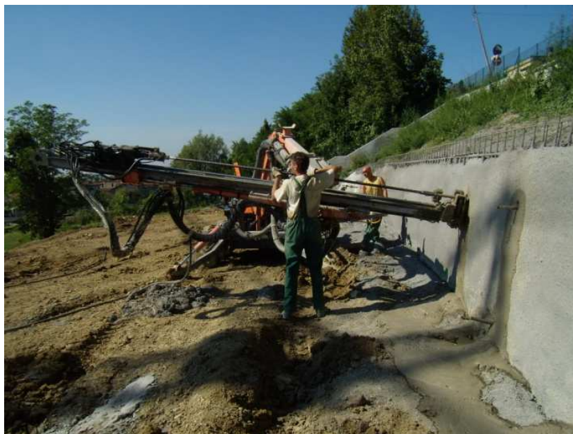
FOTO 5 - Aggiunta di una barra
