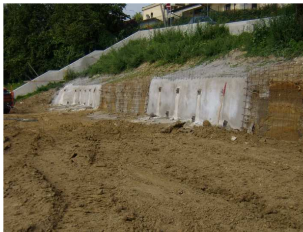
FOTO 2 - Chiodatura a settori
