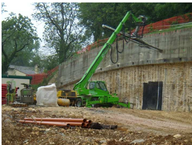
Perforatrice Tamrock HL 500 montata su Merlo
