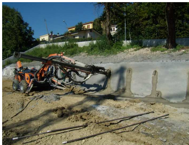
FOTO 4 - Perforazione con iniezione in avanzamento
