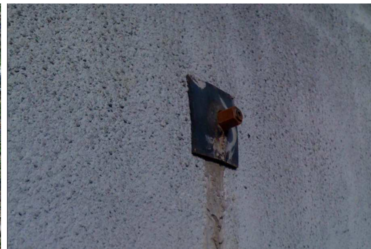
Piastra per parete chiodata con spritz beton
