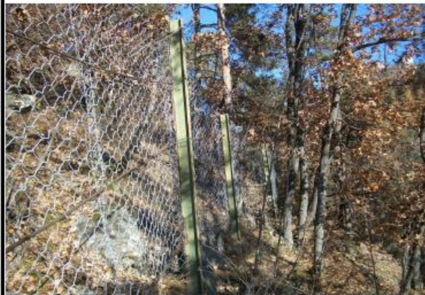
Detailaufnahme "Steinschlagschutzzaun"
